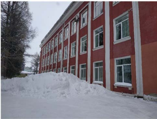
Рис. 2. Объект геотехнического мониторинга
